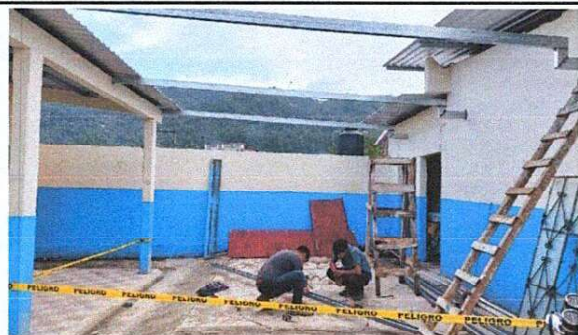
Foto 3: Se observa la instalación de estructura y techo frente a la cocina.
