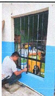
Foto 5: Se observa la instalación de ventana tipo balcón con ventilación, así mismo se pinta de negro.
