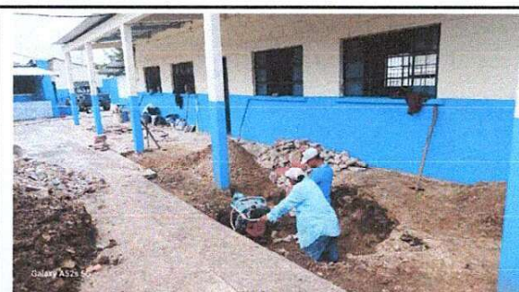
Foto 6: Se observa la desinstalación del piso y se compacta la tierra ya que se encontró un basurero.
