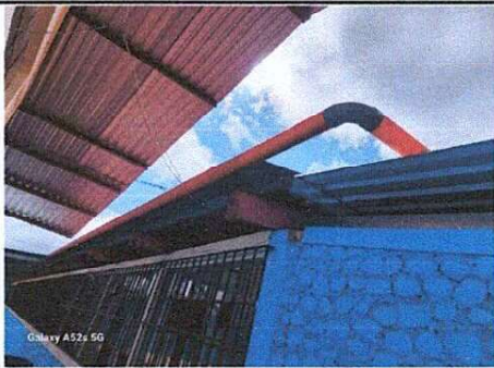
Foto 7: Instalación de Canal tipo PVC, y bajada de agua pluvial.
