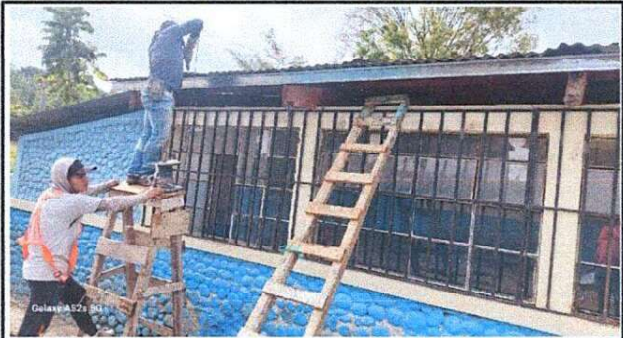
Foto 8: Se observa la sustitución de la viga de madera por costanera de metal.
