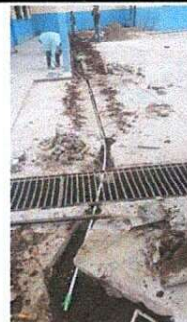
Foto 12: Instalación de tubería de PVC para distribución de agua en cocina y lavamanos.
