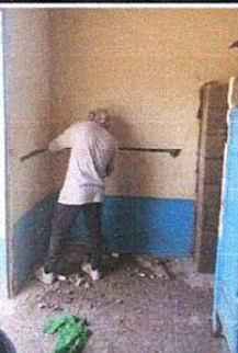
Foto 11: Se marca una escuadra para instalar lavamanos de concreto y azulejo.
