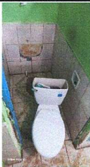
Foto 9: Se instalan 2 inodoros nuevos en el baño de docentes, y se sustituyen accesorios en inodoros.
