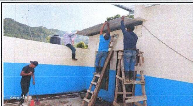
Foto 1: Se observa la instalación de lámina en la cocina
